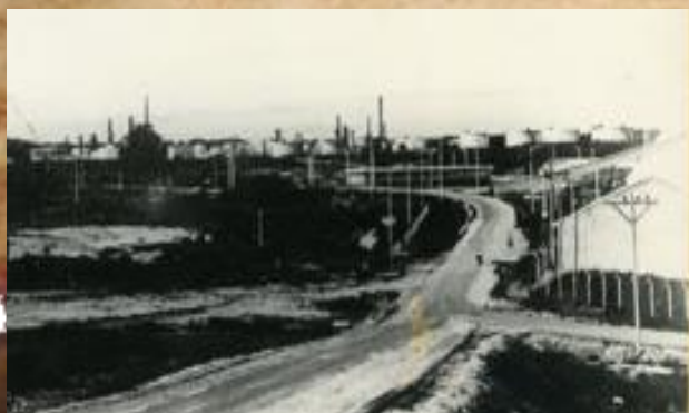
Zona Industrial de Mamonal, 1970 – Fuente: Fototeca UTB
